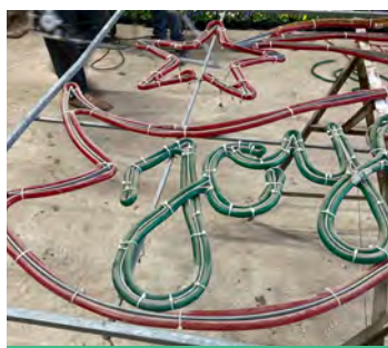
Ancien éclairage défectueux
